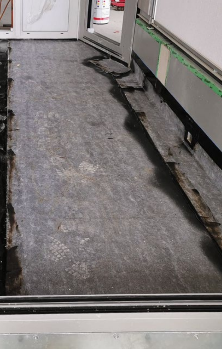
Die Dampfbremse EGV3.5 v flam, die Dämmung PIR Premium 60mm und die Unterbahn EGV3.5 v flam sind bereits verlegt. Es folgt die Oberbahn mit EP5 WF S flam.
